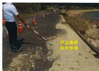
写真② 打上痕跡状況
