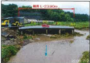
③A2橋台背面より
