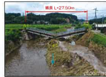
③P1橋脚 下流側より
