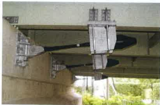
▲ 耐震補強（橋梁）
