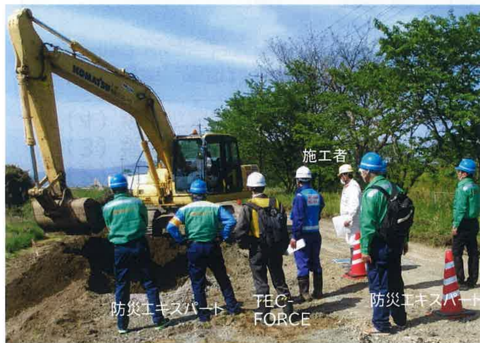
▲ 被災した堤防の復旧方法を施工者等と協議 (H28年熊本地震 緑川)
