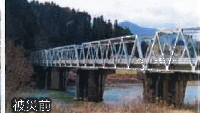
西瀬橋（人吉市）
