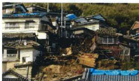
資料：福岡県土木整備部砂防課HPより 福岡県西方沖地震の被害
