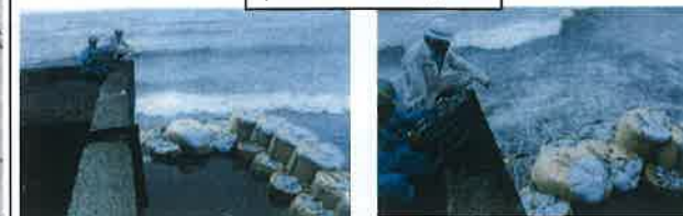
③仮締切(大型土のう工)崩壊状況
