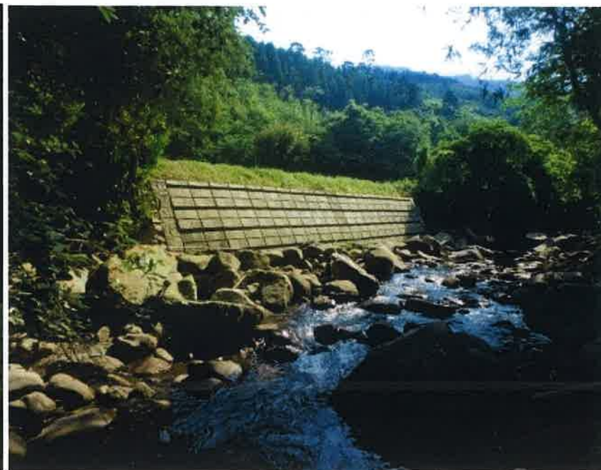
河床材料との適合性の良い寄せ石を 行った事例（大平川：宮崎県）
