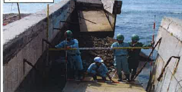
②全景(+20.7付近)
