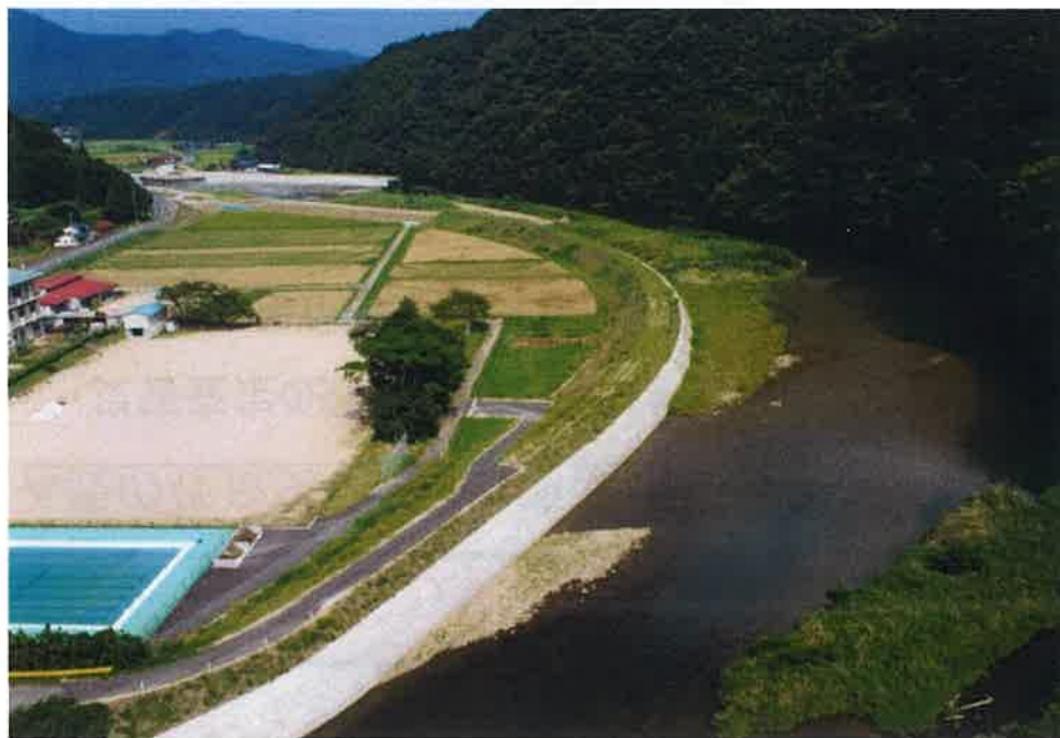
片岸拡幅で山付きの河畔林を保全して 改良復旧した事例（田万川：山口県）
