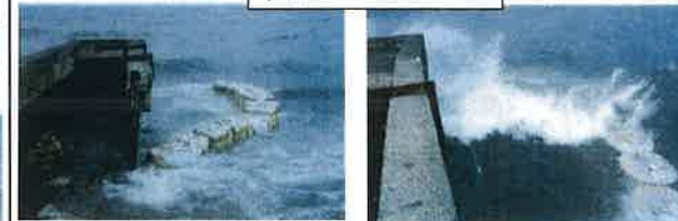
③仮締切(大型土のう工)崩壊状況
