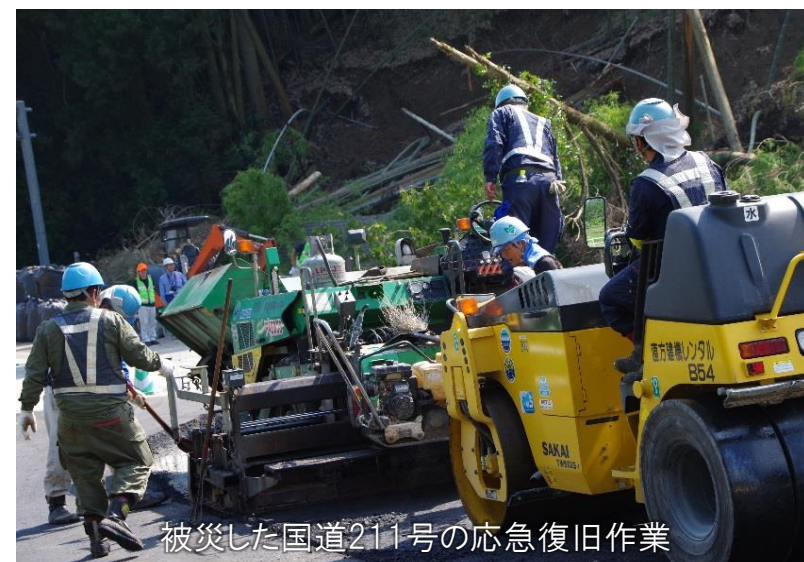
荷原川の流木撤去作業
