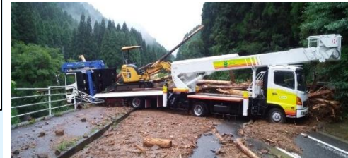
▲ 道路の啓開作業
