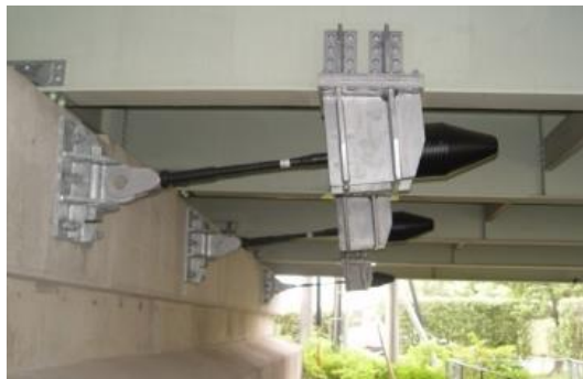
▲ 耐震補強（橋梁）
