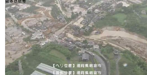
▲ 防災ヘリからの被災調査
