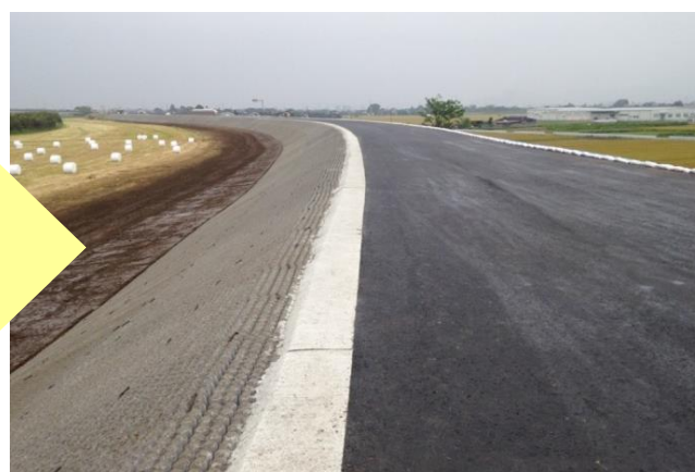
△応急復旧工事が完了した堤防
