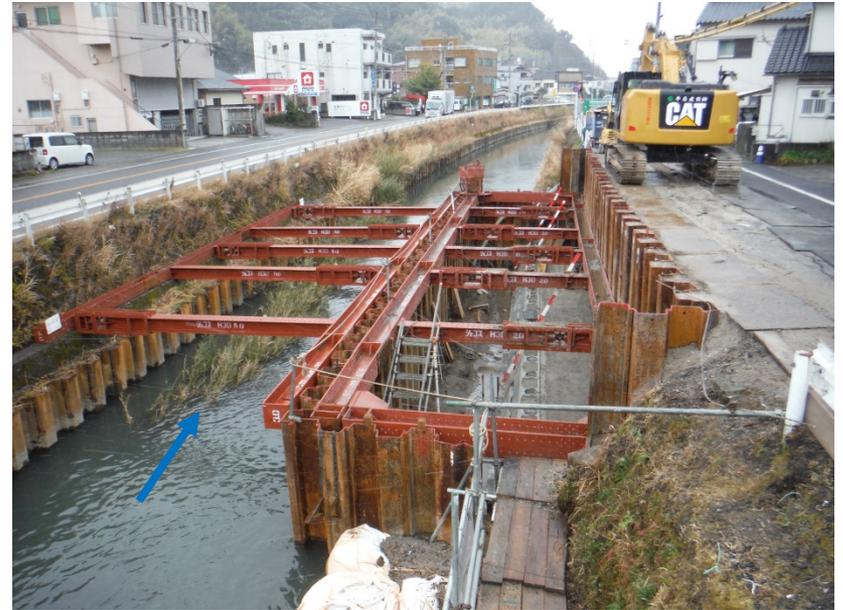
大型土のう工 → 矢板締切工への変更
