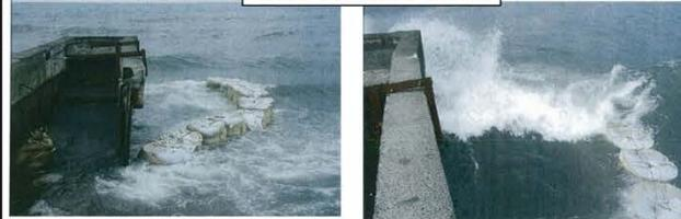
③仮締切(大型土のう工)崩壊状況
