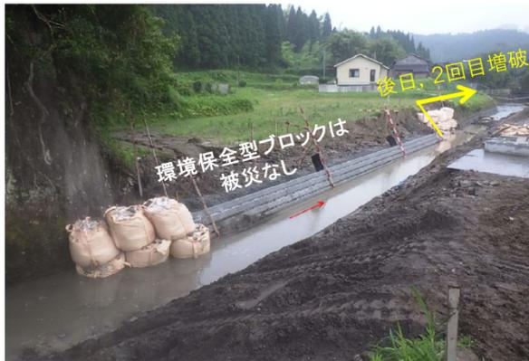
2回目の増破は梅雨期の6月であった。例年、6月は降雨量の多いことがわかっていたことや、1回目の増破について、直接の原因ではないものの、河川内に掛樋を設置したままの状態でも出水を受けたことから、掛樋を撤去し、万全の体制で出水対策とすべきであった。
