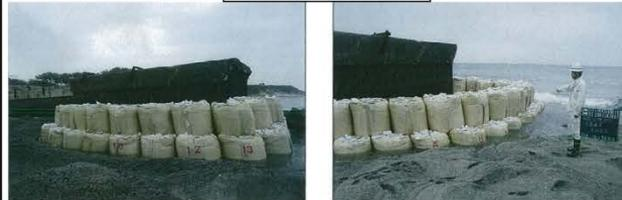
②仮締切(大型土のう工)崩壊状況
