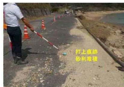
写真② 打上痕跡状況
