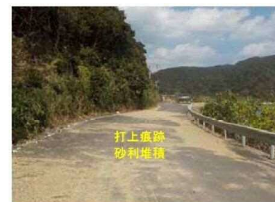
写真③ 打上痕跡状況
