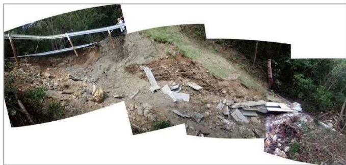
⑬崩壊斜面全景
