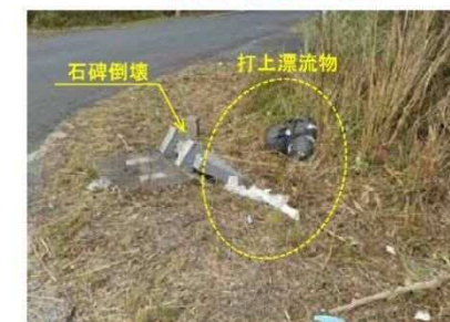
写真⑥ 打上痕跡状況
