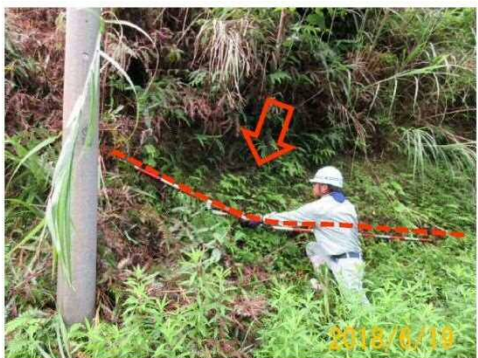
写真⑱ 右翼部 法面の押出し
