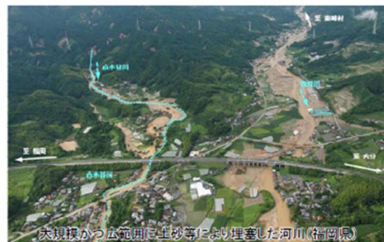
大規模かつ広範囲に土砂等により埋塞した河川（福岡県）
